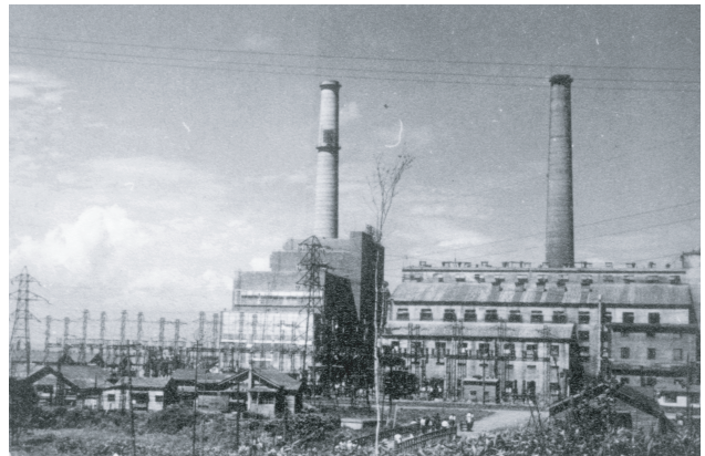
砂川第2発電所(左)、右は砂川発電所
